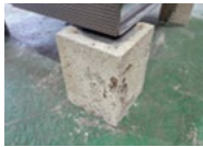
콘크리트 기초 (사각기초)
